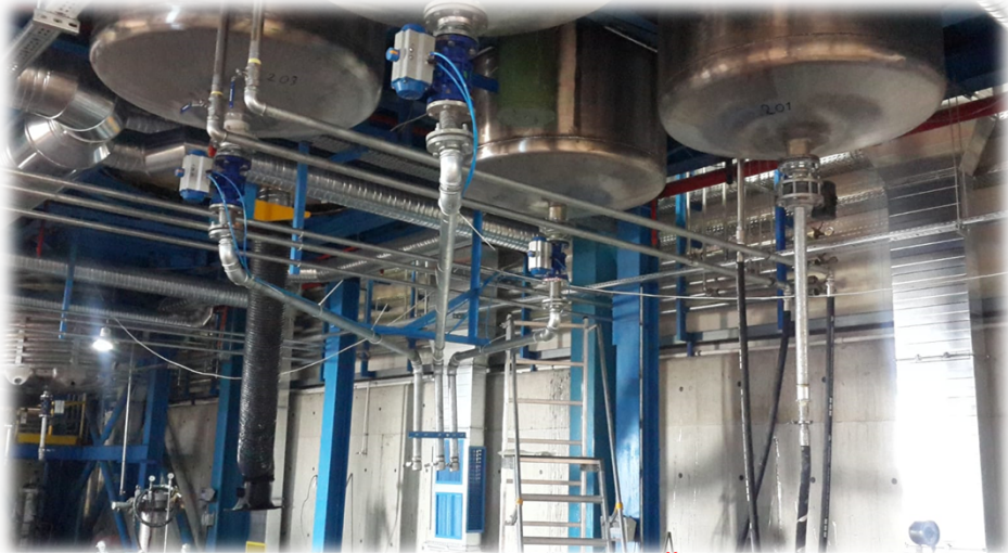
Server Boya Gıda Boyası Üretim Kazanları
